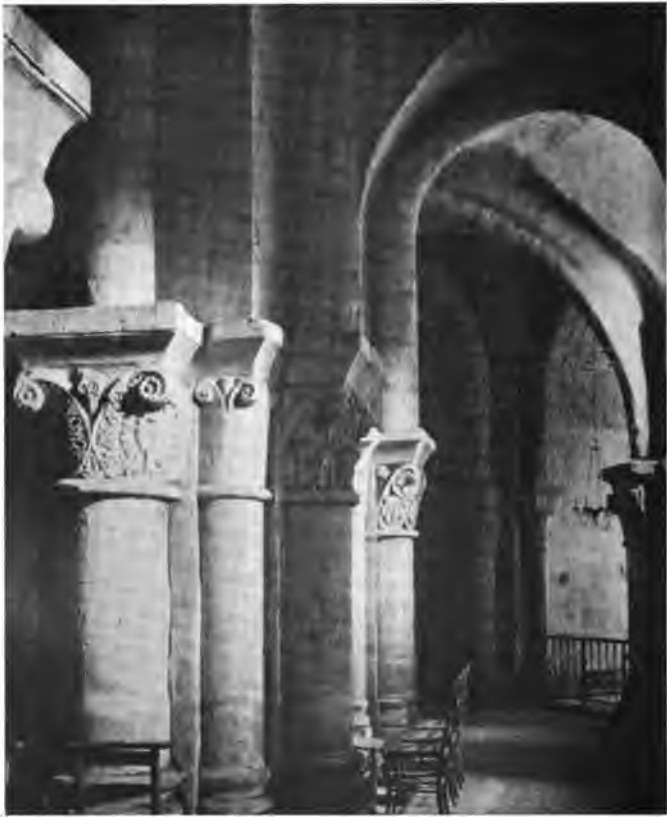
Fig. 146. — Voûte d'arêtes sur les bas-côtés du chœur dans la crypte de l'église Saint-Eutrope à Saintes. Arcs doubleaux de forme torique prolongeant la colonne.
